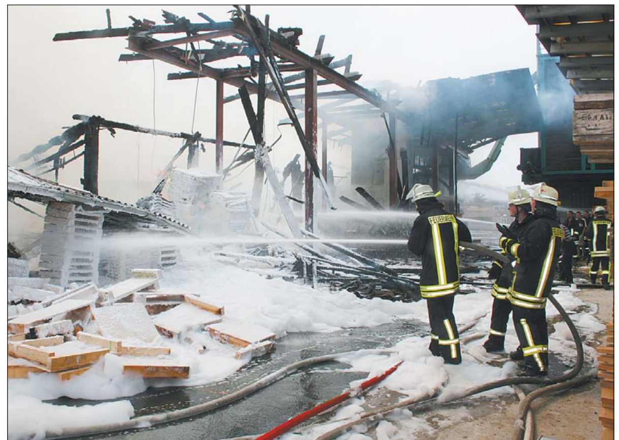
Die Stahlträger in der ausgebrannten Ruine ragen wie | dass »hier jemand nachgeholfen hat«. Die Kripo hat eine Anklage in den Himmel: Der Firmenchef vermutet, | Ermittlungen zur Brandursache aufgenommen.
